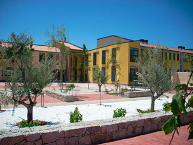
Entrada del centro
